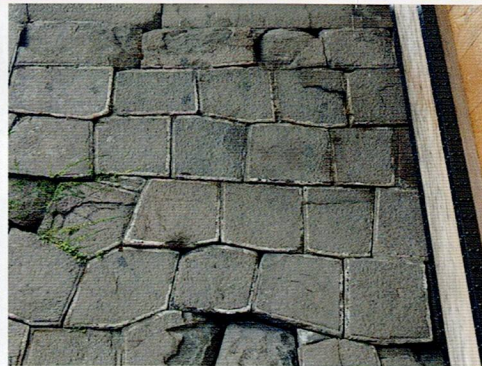
②H013面 金場取り残し積み・目地漆喰
