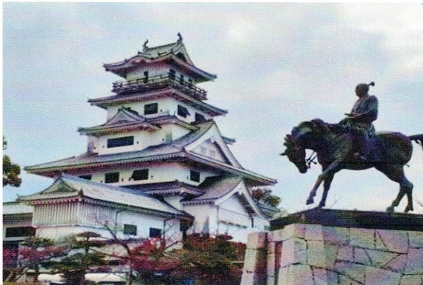
高虎が創始した層塔型の今治城一六〇二年（慶長七）に築城。関ヶ原の戦いの戦功により、伊予半国二十万石を拝領した高虎が、瀬戸内海に面した海岸に築いた平城で、豊臣家を慕う西国大名を監視する役割を担っていた。広大な水堀と反のない直線的な石垣、脆弱な地盤を安定させるための幅広い犬走り（石垣の下の道）、侵入者の方向感覚を失わせ、能率的な都市経営を目指した升目状の城下町設計など、最新の技術とアイデアを盛り込んで築かれており、高虎の代表作とも評されている。
